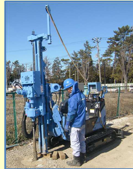
ボーリング試験
