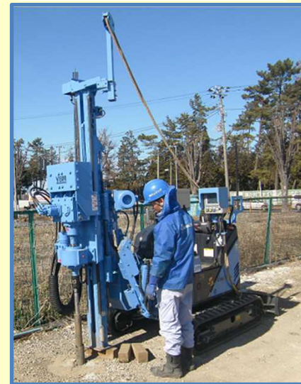
ボーリング試験
