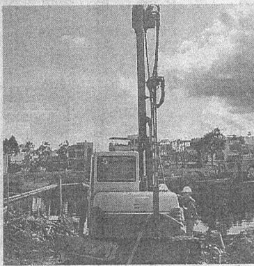
地盤改良の試験施工の様子(ベトナム)
