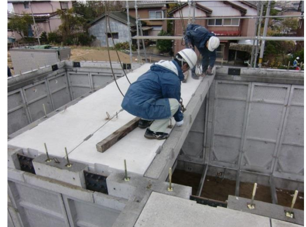
パネル住宅の施工風景
