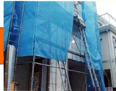
防水・断熱検査
