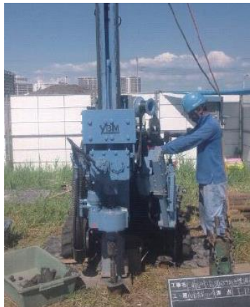
ボーリングマシンを活用した埋設
