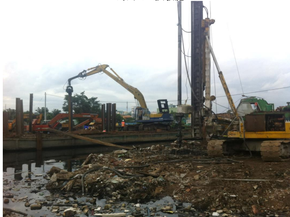
河川での試験施工
