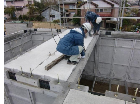
パネル住宅の施工風景
