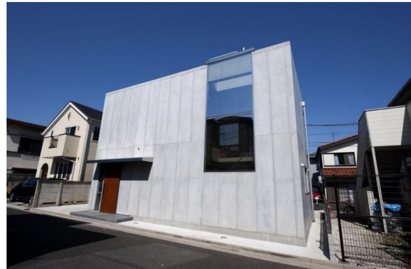
GRCを使用した住宅
