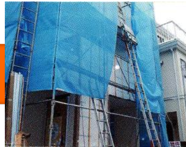
防水・断熱検査
