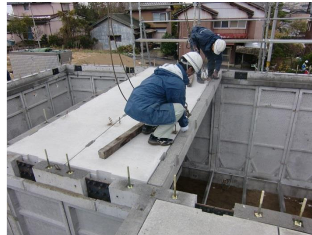
パネル住宅の施工風景
