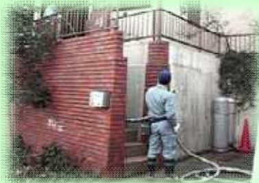
注入箇所までホースを設置
