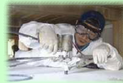
床下での樹脂注入作業
