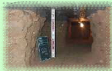
基礎下トンネル
