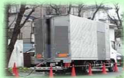
資機材一式搭載した施工トラック
