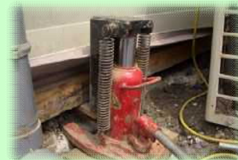
ジャッキ設置(下づめ)
