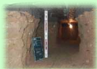
基礎下トンネル
