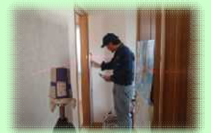
施工中のレベル管理
