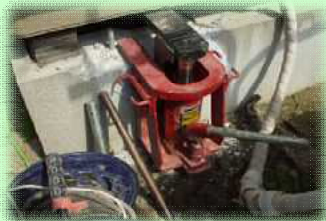
ジャッキ設置(上づめ)
