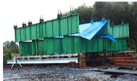
写真-2 載荷試験実施状況 (千葉県野田市)
