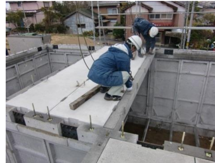
パネル住宅の施工風景
