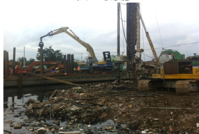
河川での試験施工
