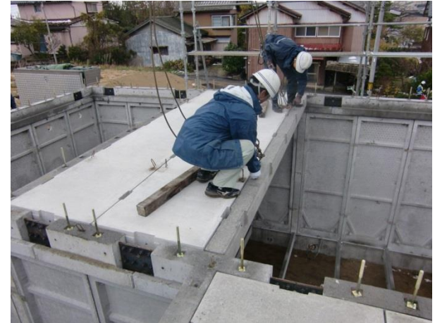
パネル住宅の施工風景
