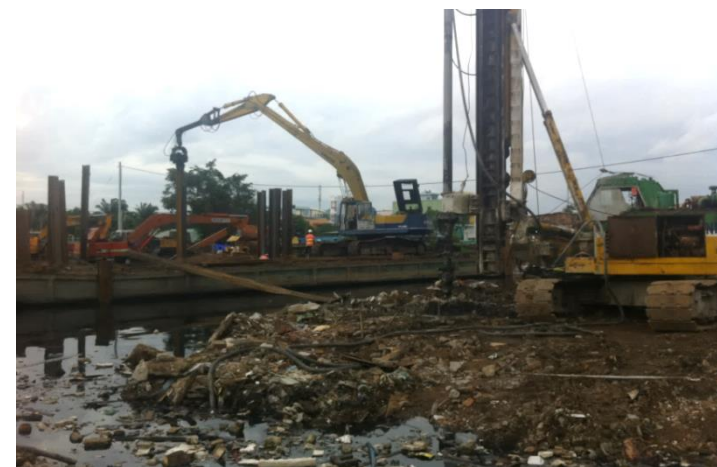
河川での試験施工
