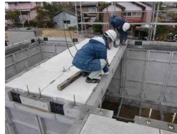
パネル住宅の施工風景
