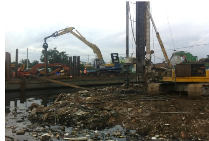
河川での試験施工
