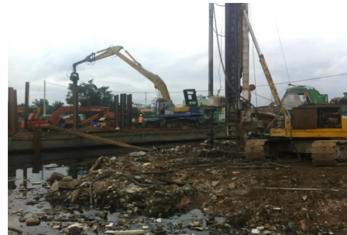
河川での試験施工
