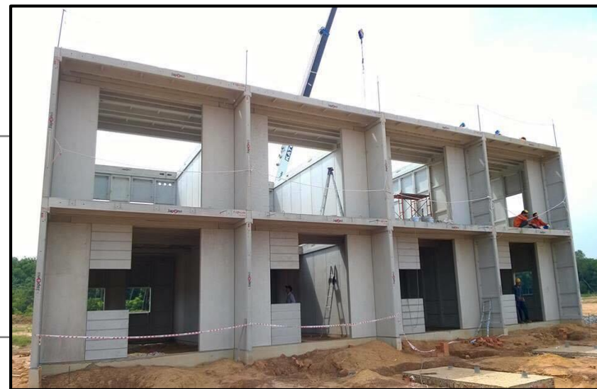
タウンハウス現場写真
