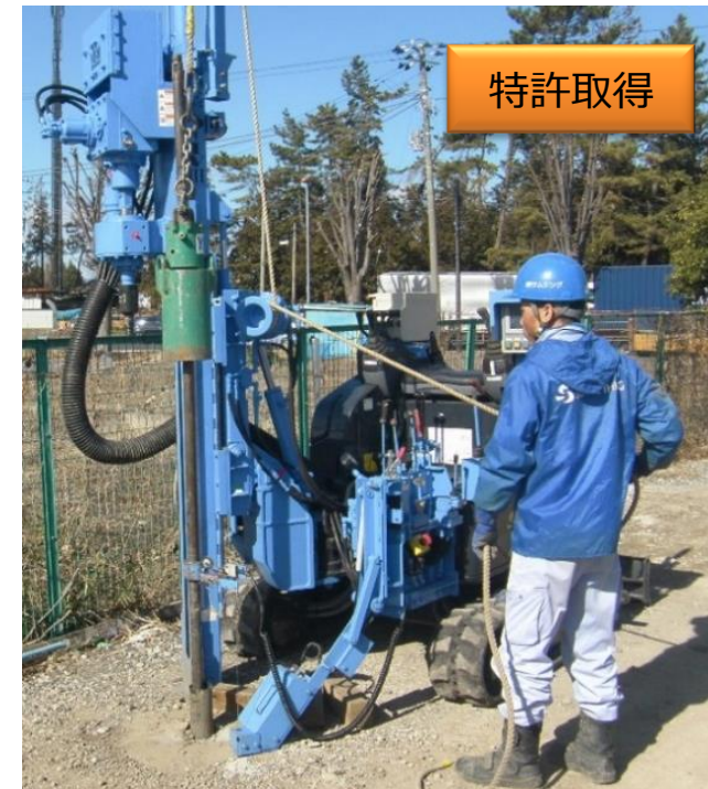
独自開発のボーリングマシン 「地盤王ホリ・ススム」
